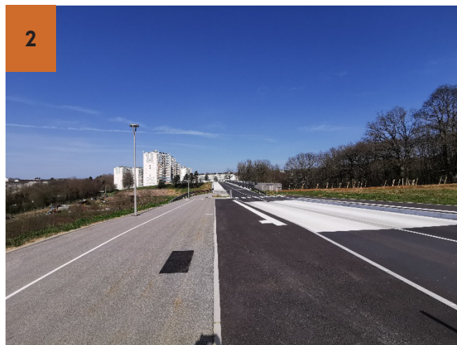
Passerelle au dessus de l'A20
