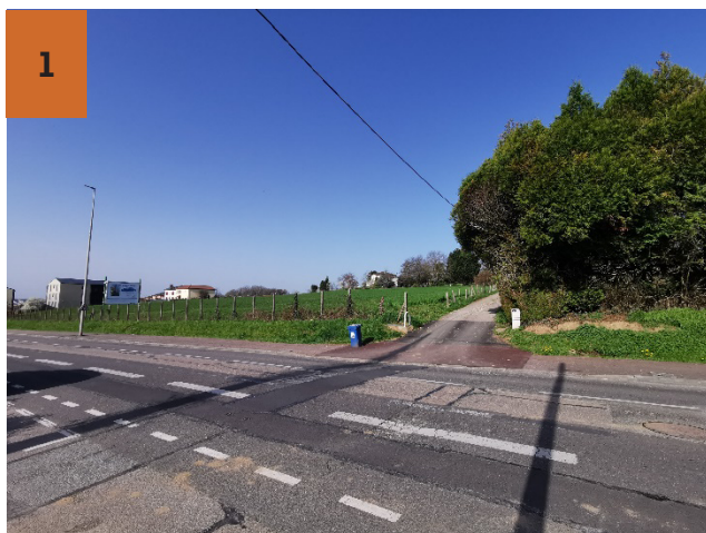
Vue du secteur depuis l'avenue Aristide Briand
