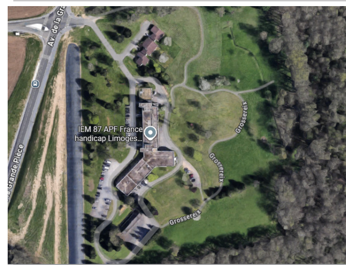
Photographie aérienne des bâtiments vacants - Source : Google Maps
