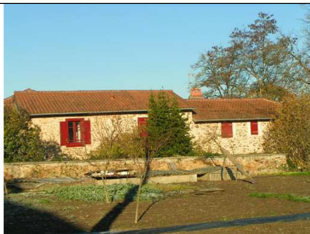
Vue depuis rue Euclide
