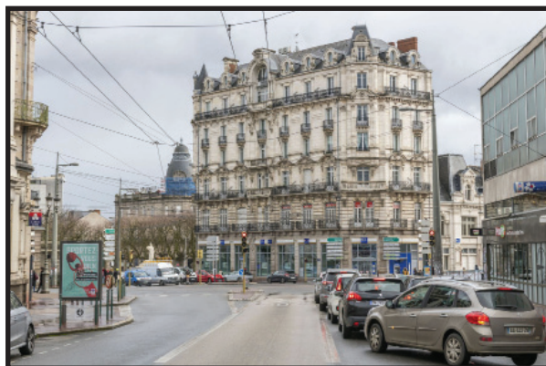
Le Central Hôtel, photographie de Laurent Lagarde & Thierry Laporte, 2020 © Ville de Limoges
