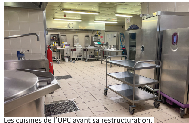
Pendant les travaux.
