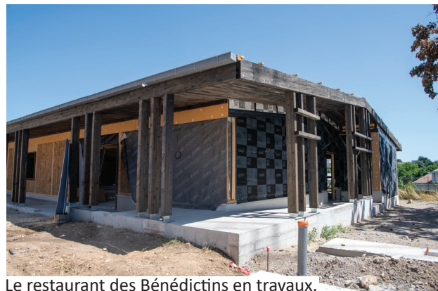
Le restaurant des Bénédictins en travaux.
