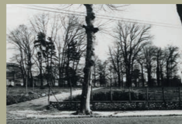
Entrée rue É. Labussière au début des travaux de réhabilitation - 1967
