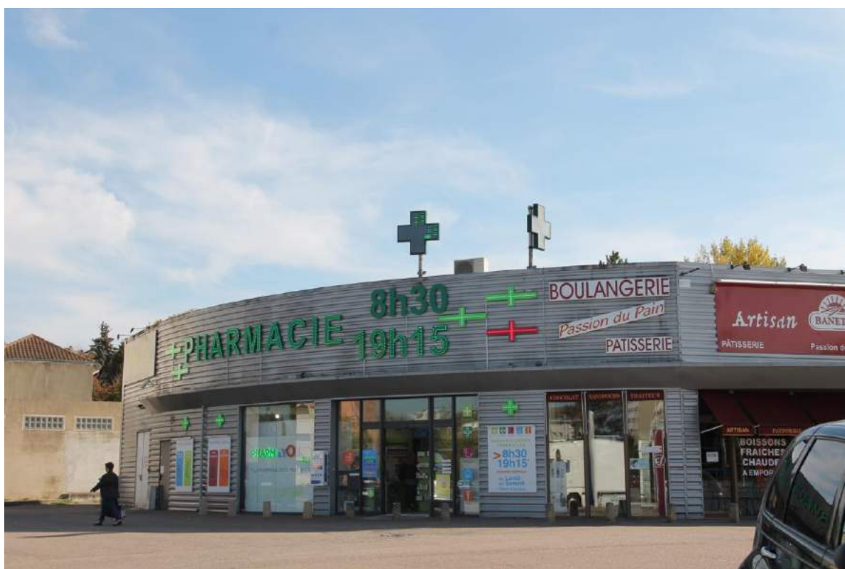
Boulevard des Vanteaux Enseignes lumineuses
