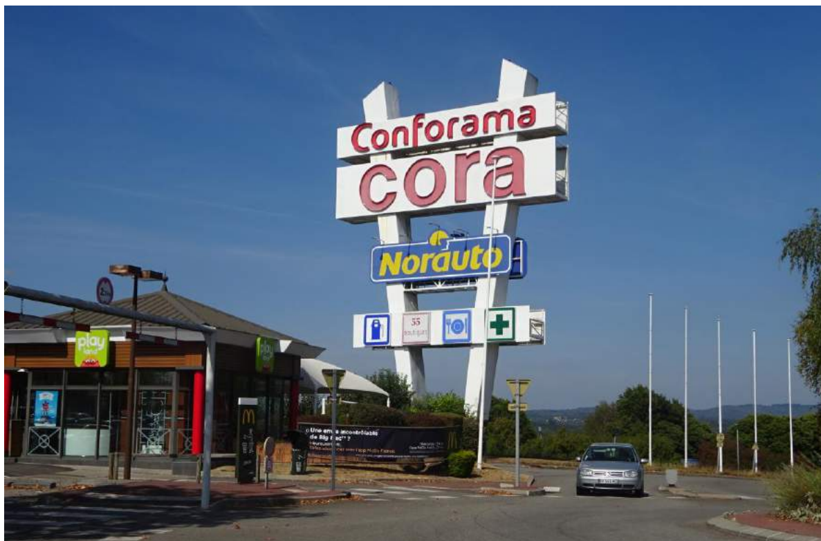
Centre commercial Beaubreuil – Surface et hauteur illégales
