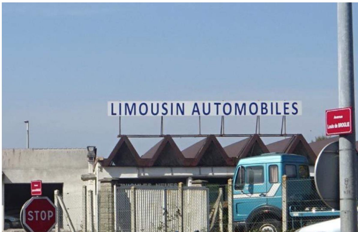
Avenue de Broglie – Enseigne en toiture illégale (structures apparentes et panneau de fond))
