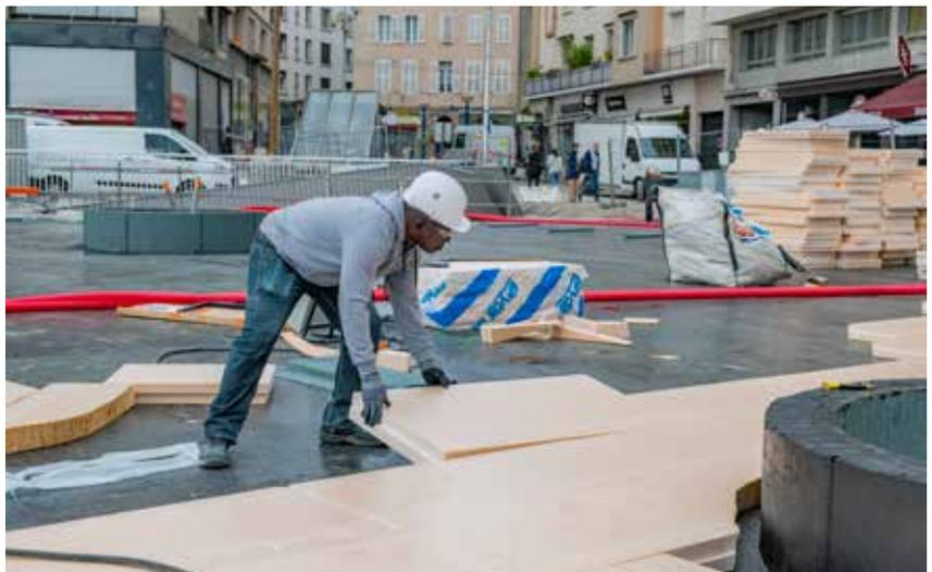
Septembre : pose de plaques de Styrodure, matériau léger destiné à mettre à niveau la surface de la place avant le coulage de la sur-dalle.
