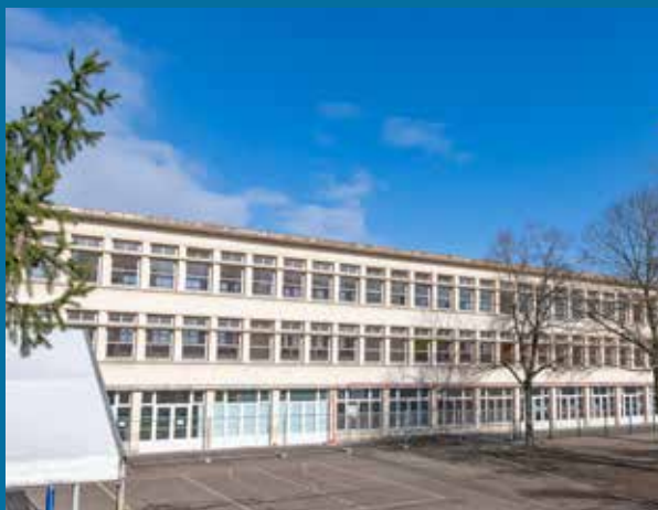
Bâtiment du site scolaire Condorcet Roussillon qui est en cours de désamiantage et sera restructuré. À gauche le préau provisoire sera démonté
