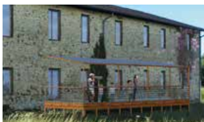
À l'arrière du bâtiment, un observatoire pour les oiseaux. ©Projection architecture François Samy
