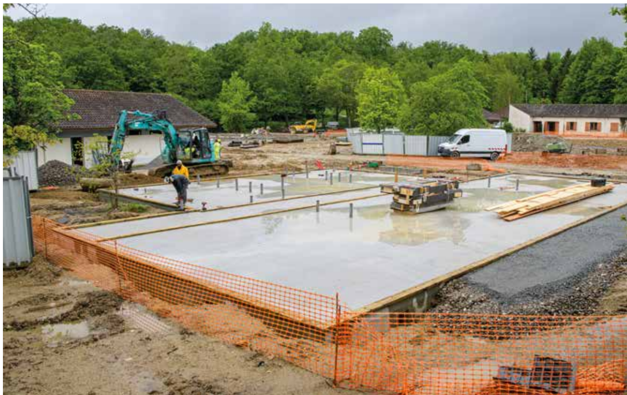
Les dalles béton qui vont accueillir les futurs bâtiments de l'accueil de loisirs d'Uzurat sont coulées.
