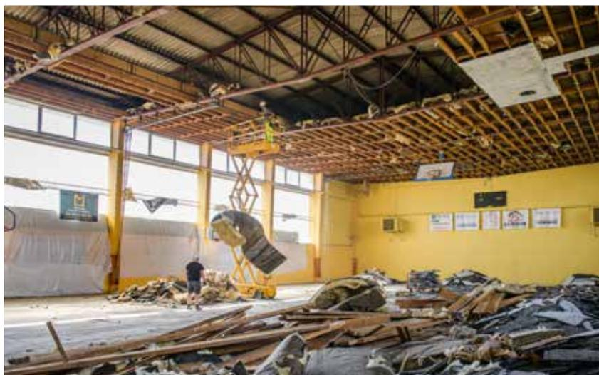
Au gymnase Jean-Macé, la dépose du plafond en juin a précédé la réfection de la couverture. Des panneaux photovoltaïques seront installés. Pour le déploiement des panneaux photovoltaïques, la Ville a obtenu des financements de la Région pour certaines études, du Département et de l'État au titre de la DSIL, du Fonds Vert ou du FNADT selon les opérations.
