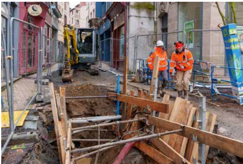
Rue Lansecot, après les travaux sur les réseaux enterrés, les aménagements de voirie et le pavage débuteront en mars. Le sol sera de niveau pour faciliter les déambulations piétonnes.
