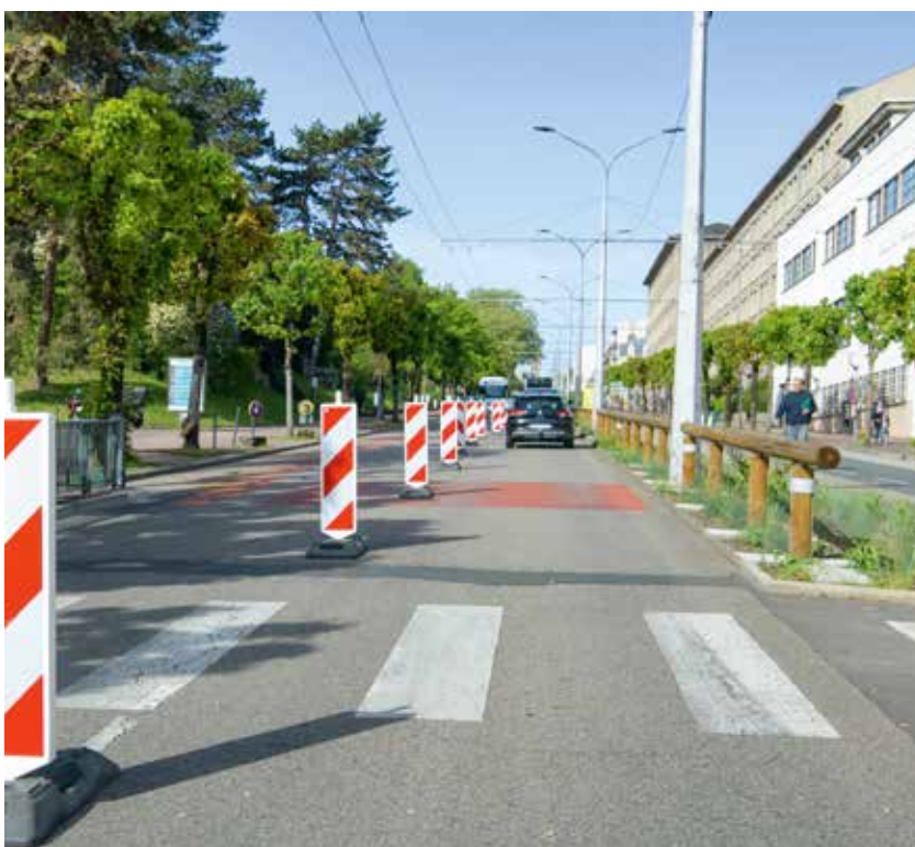
Les travaux du réseau de chaleur en faveur de la transition énergétique et du verdissement des systèmes de chauffage se poursuivent avenue Jean-Gagnant.
