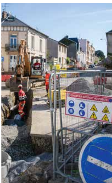
En travaux rue de Belfort.
