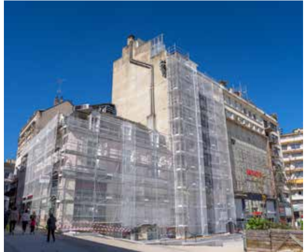
Le ravalement des façades des immeubles qui surplombent Monoprix a débuté.
