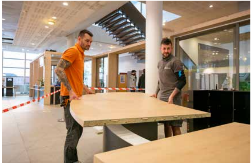
Installation du nouveau guichet d'accueil à la Bfm
