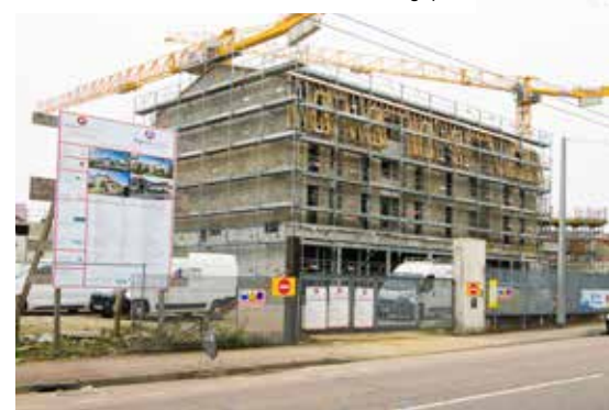
Chantier rue du Maréchal de Lattre-de-Tassigny
