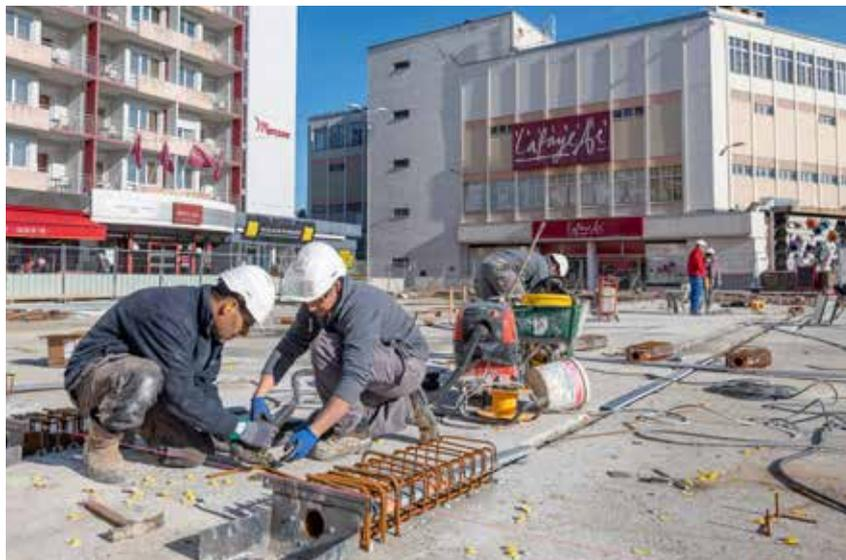
Installation des premiers câbles qui viendront renforcer la solidité de la dalle béton sur la place (système post contrainte)
