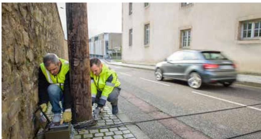
Installation d'un compteur pneumatique routier par les professionnels de la direction du domaine public de la ville. L'objectif est d'évaluer le trafic (vitesse, type de véhicule, densité de circulation, horaires) dans les rues de Limoges et de faire des préconisations d'aménagements.
