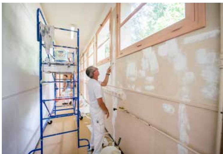
Travaux de peintures à l'école maternelle Raoul Dautry
