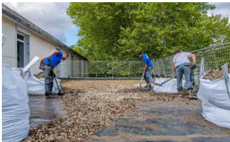
Réfection de la toiture terrasse à Madoumier
