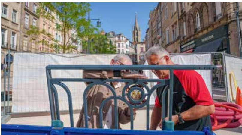
La pose de la balustrade incrustée d'émail a été réalisée durant l'été place des Bancs.
