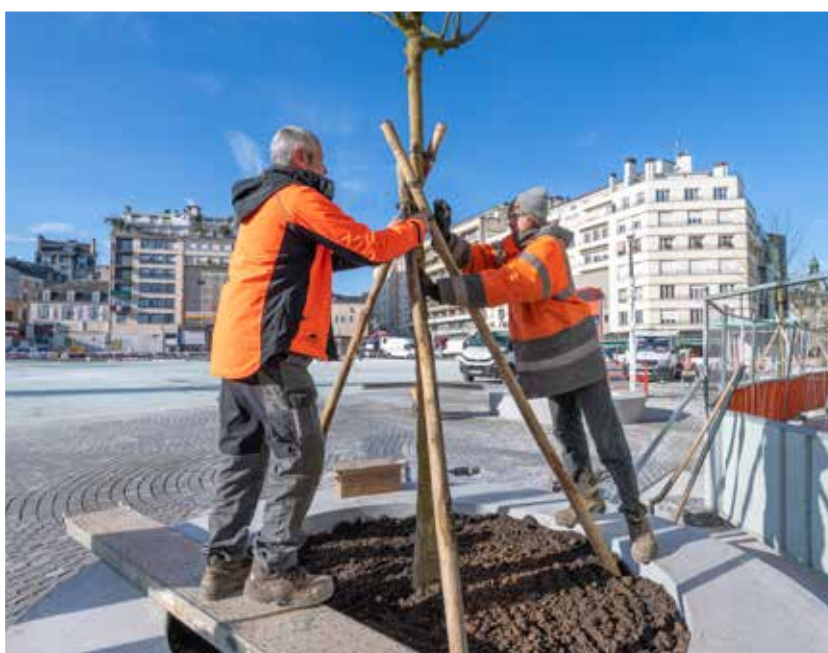
Plantation des arbres en février 2020, dans les fosses qui ont été créées au niveau -1 du parking
