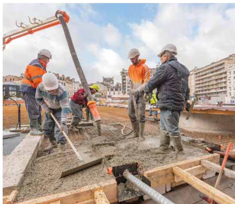
Coulage de la dalle béton sur place en mars 2019
