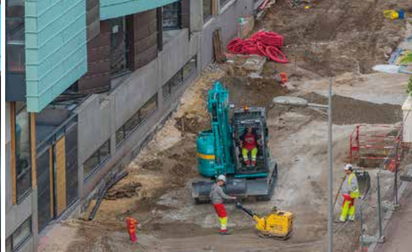
Novembre 2018 : terrassement rue Fitz-James après le passage des réseaux souterrains
