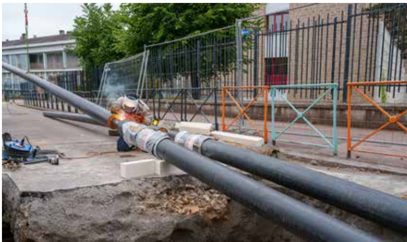
Les travaux du réseau de chaleur urbain améliorent le confort thermique avec une distribution plus efficace, réduisent les pertes d'énergie, et baissent la facture de chauffage des bâtiments raccordés. Cela permet un chauffage plus fiable, plus écologique, et des économies sur le long terme.
