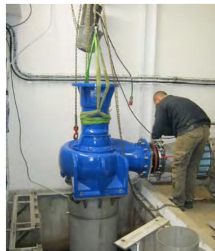
Remplacement de pompe C.A.G. à la station de production d'eau potable
