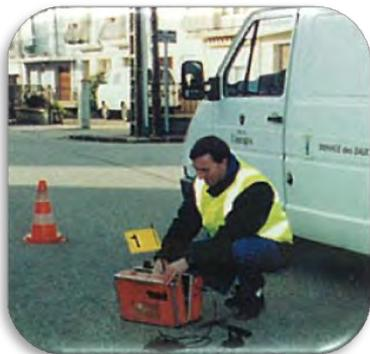
Installation d'un capteur du corrélateur.
